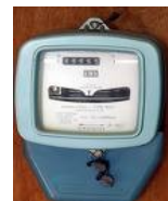
Compteur électrique pour connaître sa consommation
