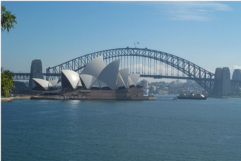
Pour traverser la baie de Sydney, le Harbour Bridge fut achevé en 1932. Ce pont en arc a une portée de 503m.
