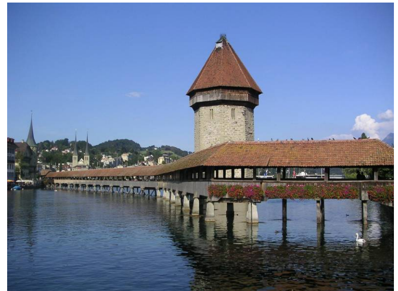
Construit en 1365 à Lucerne, le Kapellbrücke est le plus ancien pont couvert en bois d'Europe. C'est un pont poutre. En 1993, il fut partiellement détruit par un incendie. Il reliait l'ancienne ville à la nouvelle.
