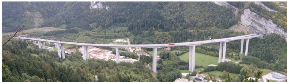
Le viaduc de Nantua est un pont à poutre avec des portées de 124m.
