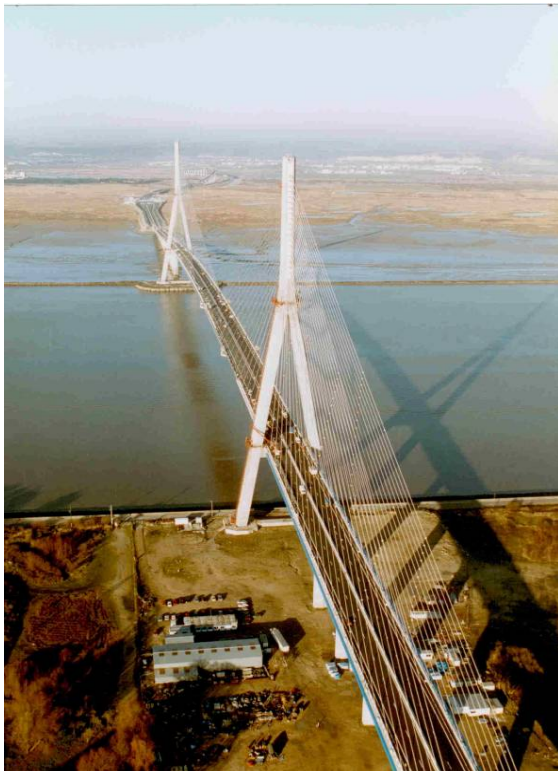
Le pont routier de Normandie est un pont à haubans d'une longueur totale de 2141 m avec un portée centrale de 856 m (1989-1995)
