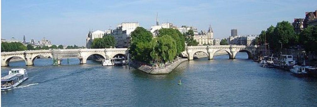
A Paris, le Pont Neuf a été achevé en 1607. C'est le plus vieux pont parisien. C'est un pont en arc. La portée entre les piles est d'environ 18m.
