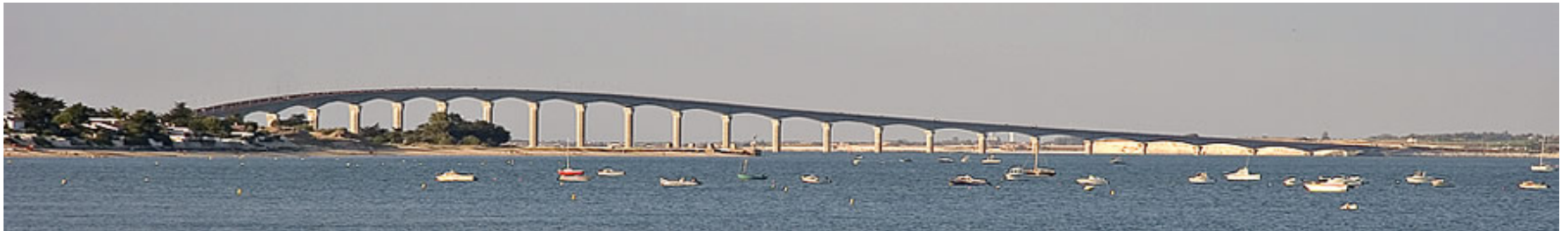
Le pont de l'Île de Ré est constitué de 6 viaducs reliés entre eux. C'est un pont à poutre d'une longueur totale de 2927 m, avec des portées de 110 m. Il a été achevé en 1988, sa construction a duré 2 ans.
