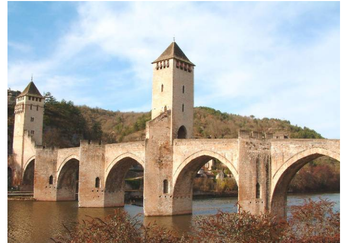
A Cahors le pont Valentré était un pont militaire. Il a été achevé en 1378. La portée entre les piles est d'environ 16,50m.
