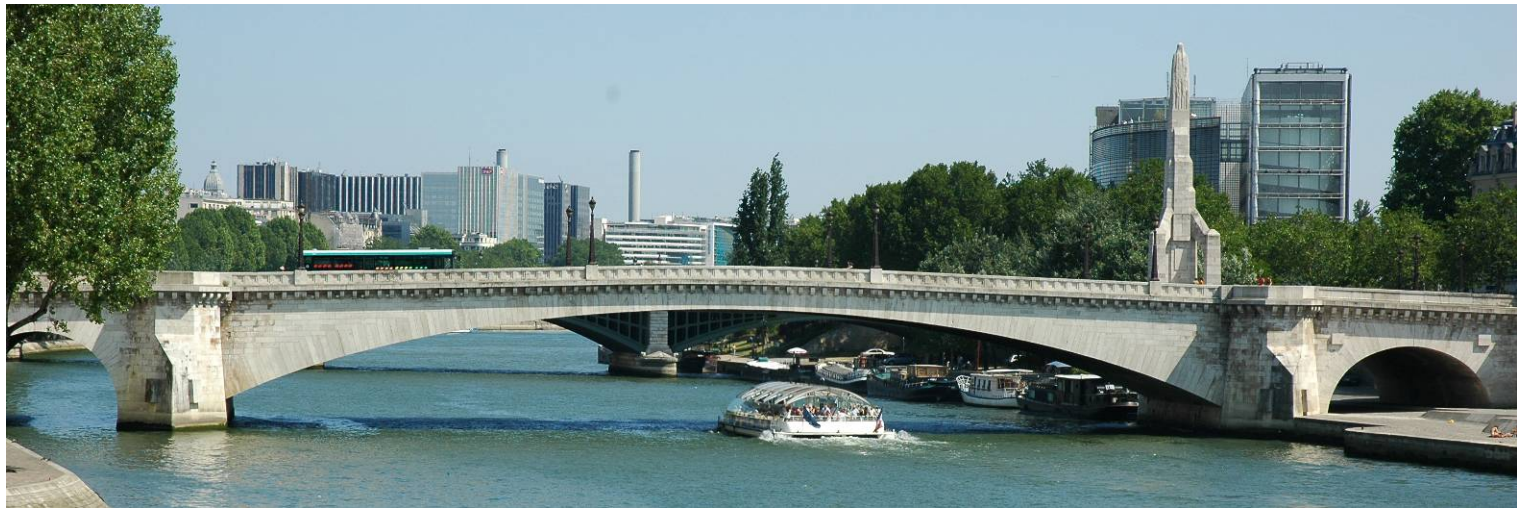
Achevé en 1930, le pont en arc de la Tournelle à Paris a une longueur totale de 122m avec une arche centrale d'une portée de 74m.
